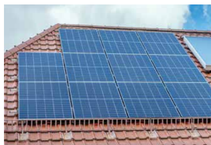
Solaranlage einheitlich auf Dach angebracht
