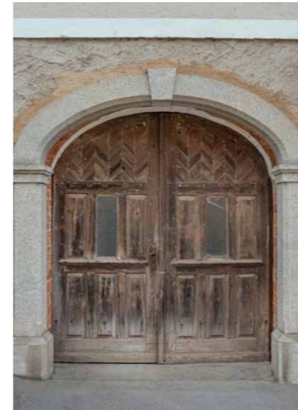
Typische Toranlage. Der Erhalt wird empfohlen
