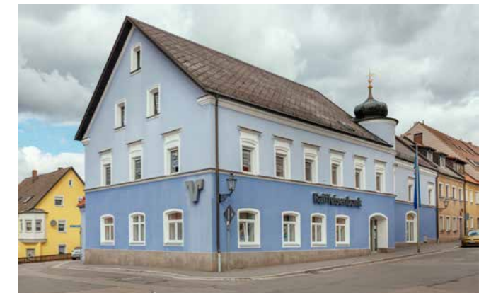
Marktplatz 24; Raiffeisenbank nach Sanierung heute
