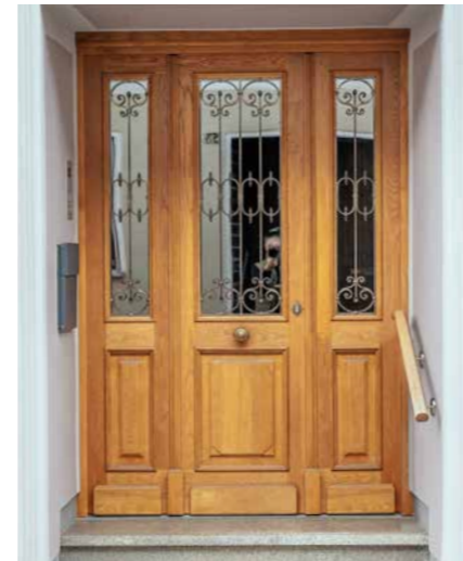
Kleine Sichtöffnung in Hauseingangstür aus Holz
