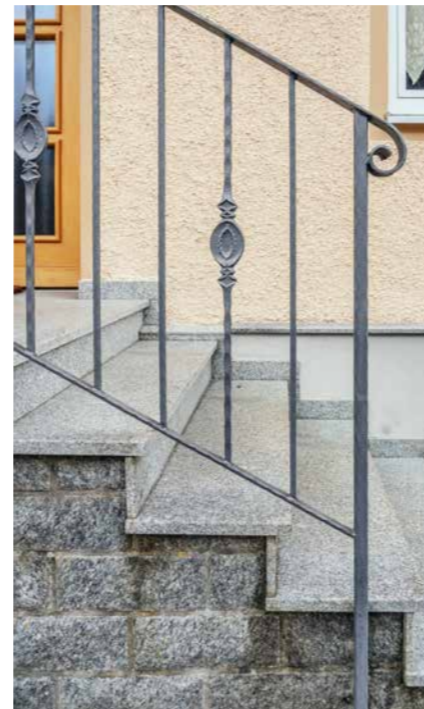
Traditionell geformte Absturzsicherung aus Schmiedeeisen
