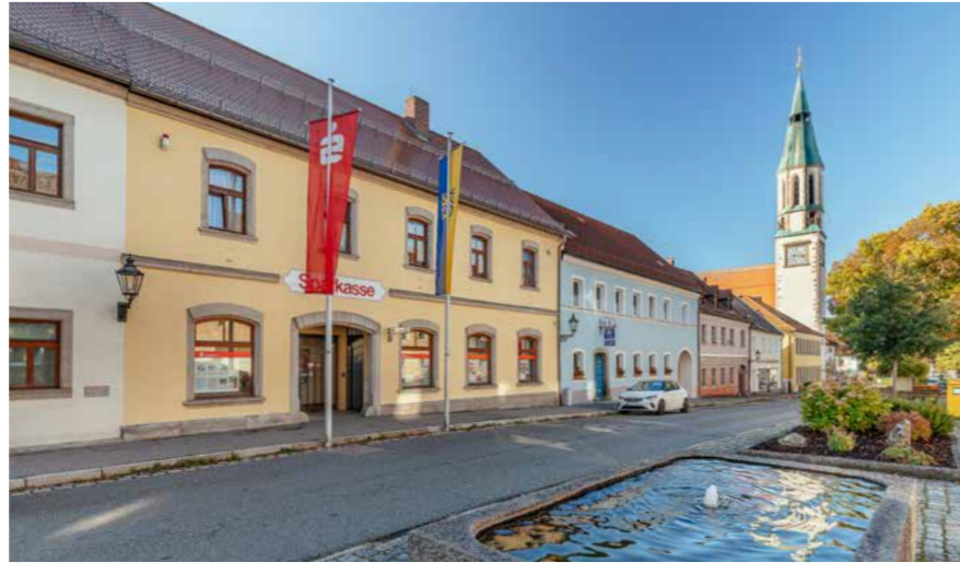
Farbige Putzfassaden prägen den Marktplatz
