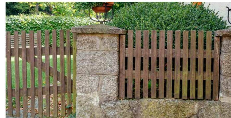
Tor aus senkrechter Holzlattung auf Holzriegel
