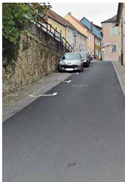
Einfassung einer asphaltierten Straße mit Pflasterstrandstreifen
