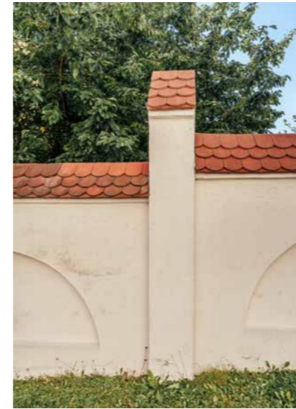
Sachgerechter Anschluss der Dacheindeckung an eine Wand
