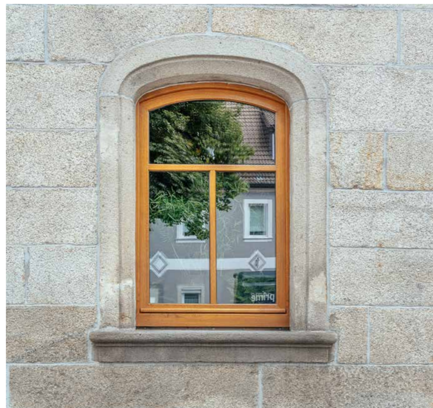
Vorbildlich saniertes Fenster mit ausgerundetem Sturz
