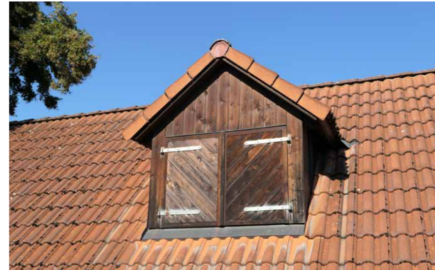
Äußerer Zugang eines Dachbereichs
