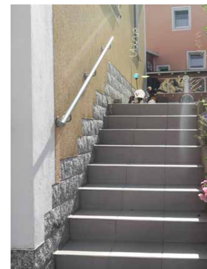
Handlauf aus Stahlrohr als Treppensicherung
