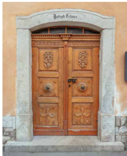
Kleine Lichtöffnung in Hauseingangstür aus Holz
