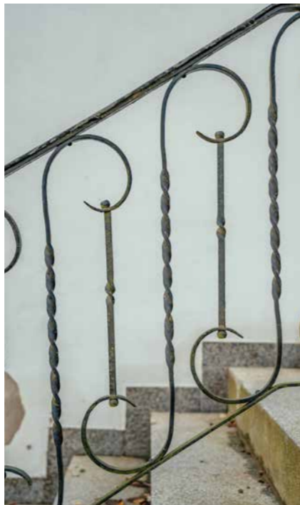
Traditionell geformte Absturzsicherung aus Schmiedeeisen
