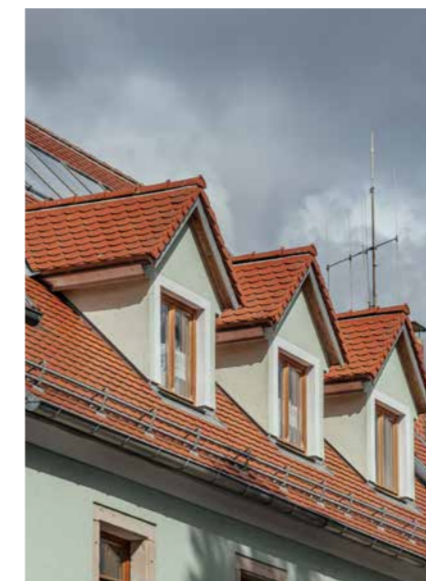
Gaubenform, Kehlendeckung und Traufbildung
