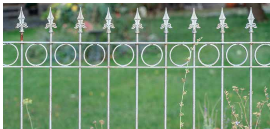
Beispiel für eine sachgerechte Einfriedung aus Schmiedeeisen
