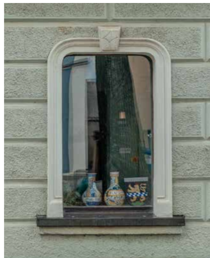
Erhaltenswertes Außenelement aus Naturstein
