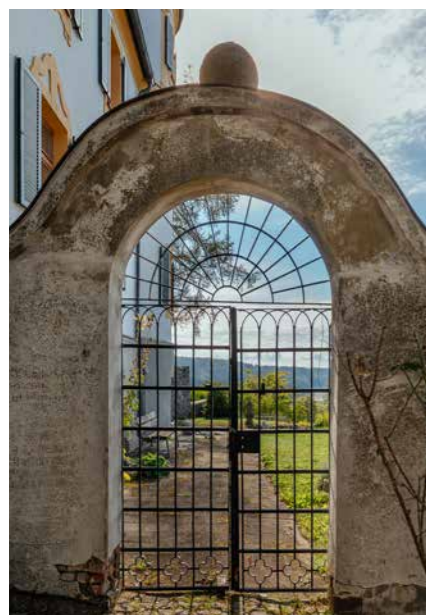
Sachgerecht: Grundstückseinfriedung aus geputztem Mauerwerk und schmiedeeisernem Eingangstor
