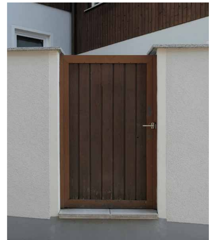
Einfriedungsmauer mit hölzerner Durchgangstür
