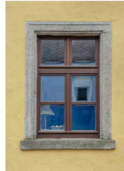
Hochstehendes Fenster mit historischer Binnengliederung
