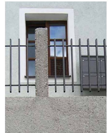
Geeignete Modernisierung mit Profilstahl und gestocktem Sichtbeton
