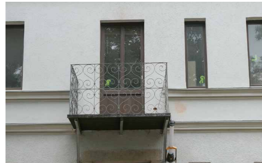
Sachgerechte Sanierung mit Schmiedeeisen und Naturstein
