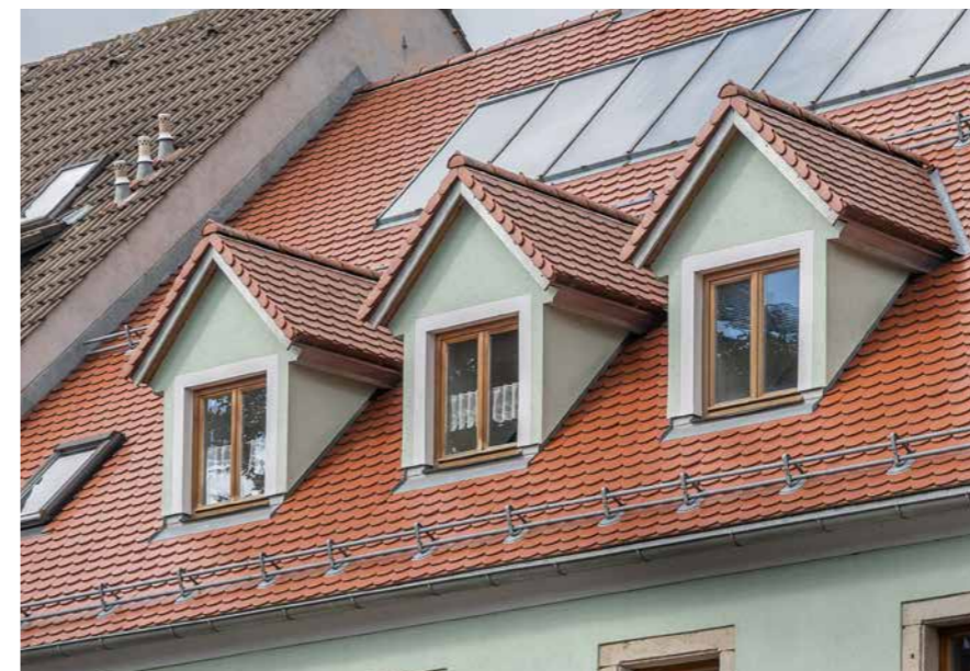
Schleppdach und Seitenflächen einer Gaube
