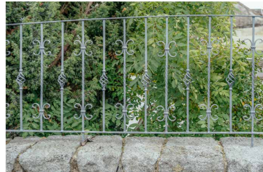
Sachgerechte Sanierung mit Schmiedeeisen und Naturstein
