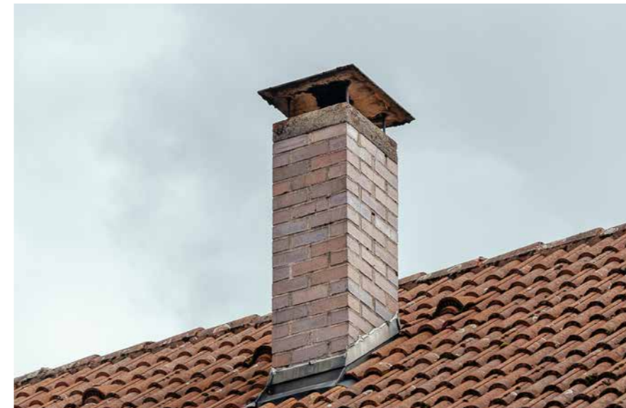
Sachgerechte Einbindung und Abdeckung Kamin
