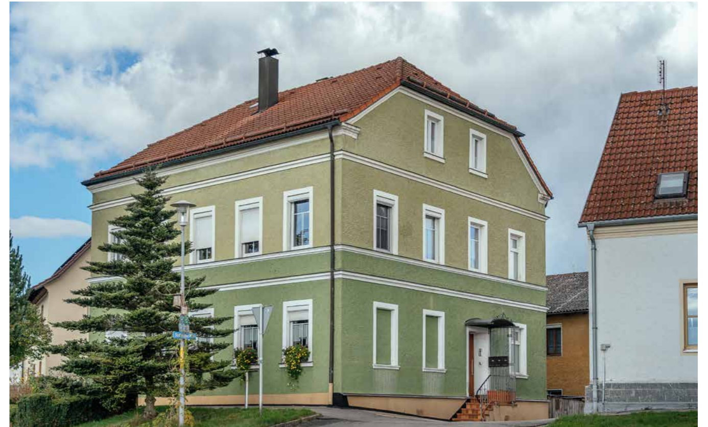
Haus mit Verschattungsanlagen
