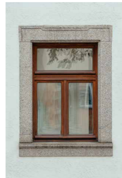
Erhaltenswertes Außenelement aus Naturstein
