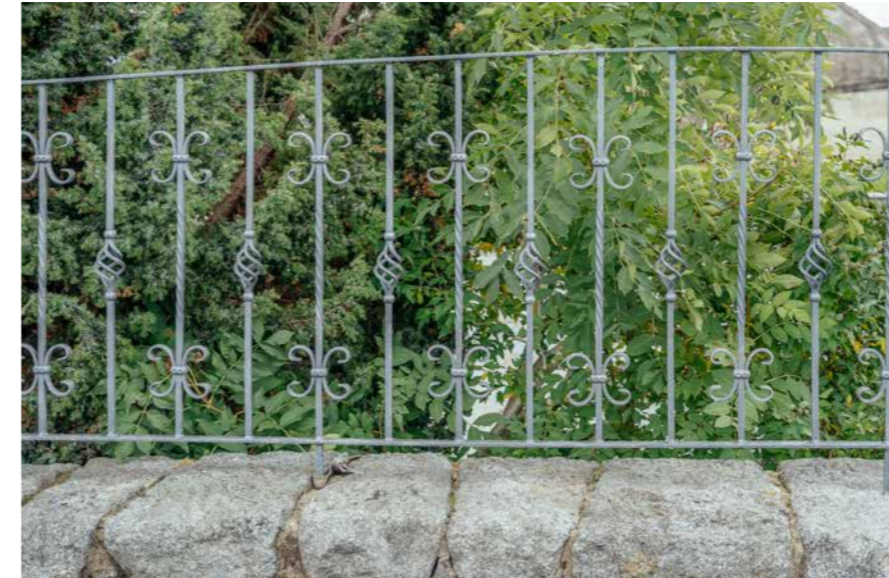
Sachgerechte Sanierung mit Schmiedeeisen und Naturstein
