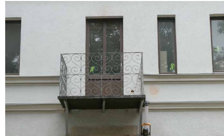
Sachgerechte Sanierung mit Schmiedeeisen und Naturstein
