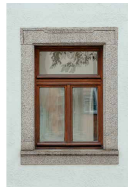
Erhaltenswertes Außenelement aus Naturstein
