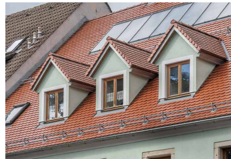
Schleppdach und Seitenflächen einer Gaube
