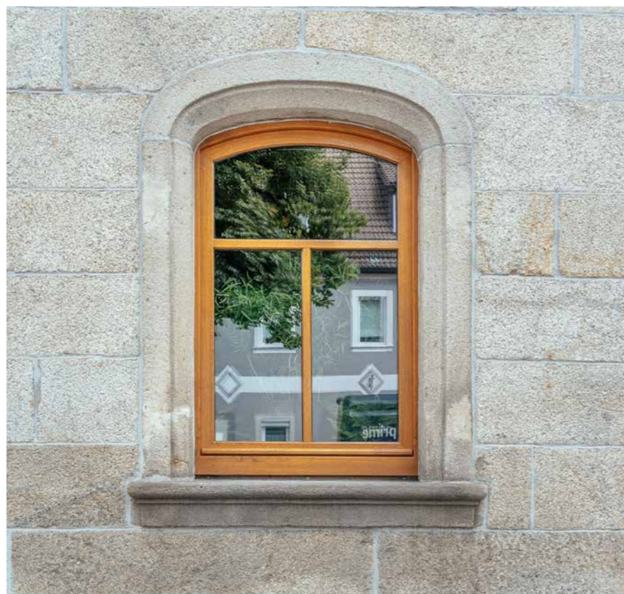
Vorbildlich saniertes Fenster mit ausgerundetem Sturz
