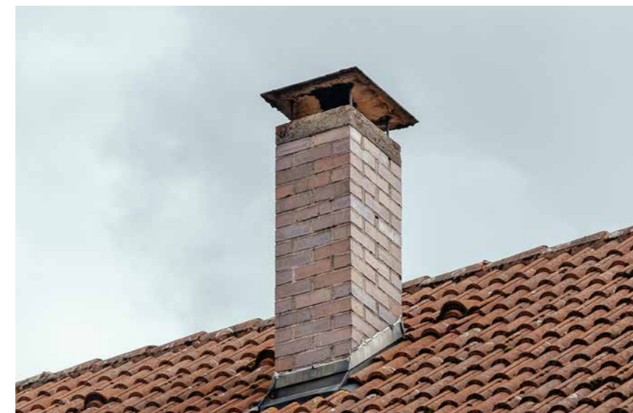
Sachgerechte Einbindung und Abdeckung Kamin
