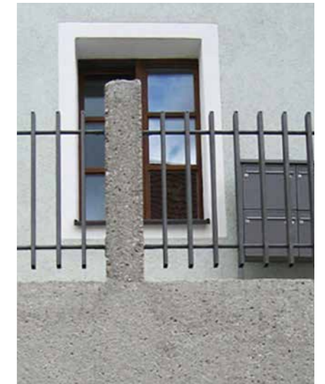
Geeignete Modernisierung mit Profilstahl und gestocktem Sichtbeton
