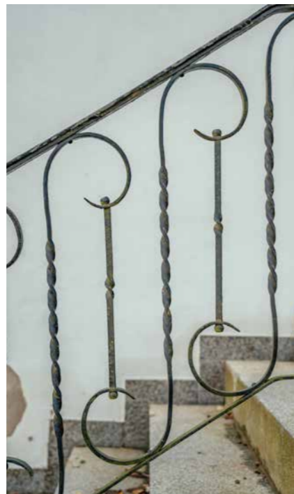
Traditionell geformte Absturzsicherung aus Schmiedeeisen
