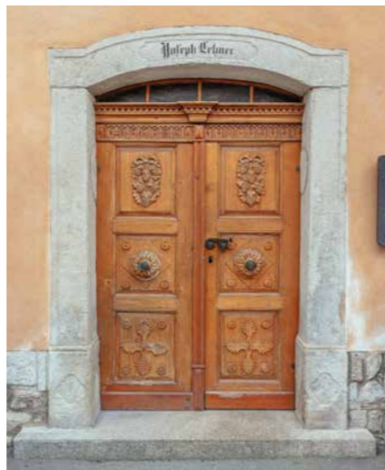
Kleine Lichtöffnung in Hauseingangstür aus Holz
