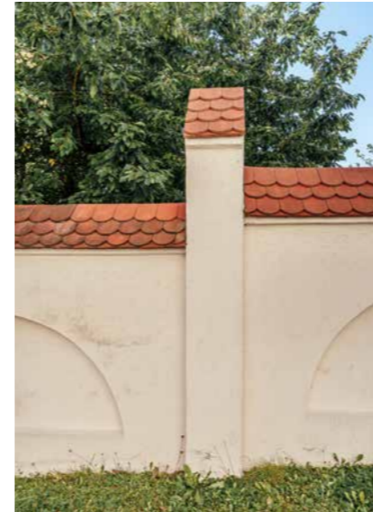
Sachgerechter Anschluss der Dacheindeckung an eine Wand
