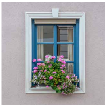
Gut proportionierte Fensterfasche mit verblechter Fensterbank
