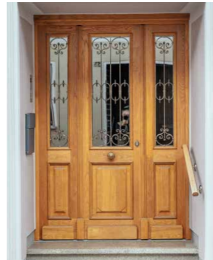
Kleine Sichtöffnung in Hauseingangstür aus Holz
