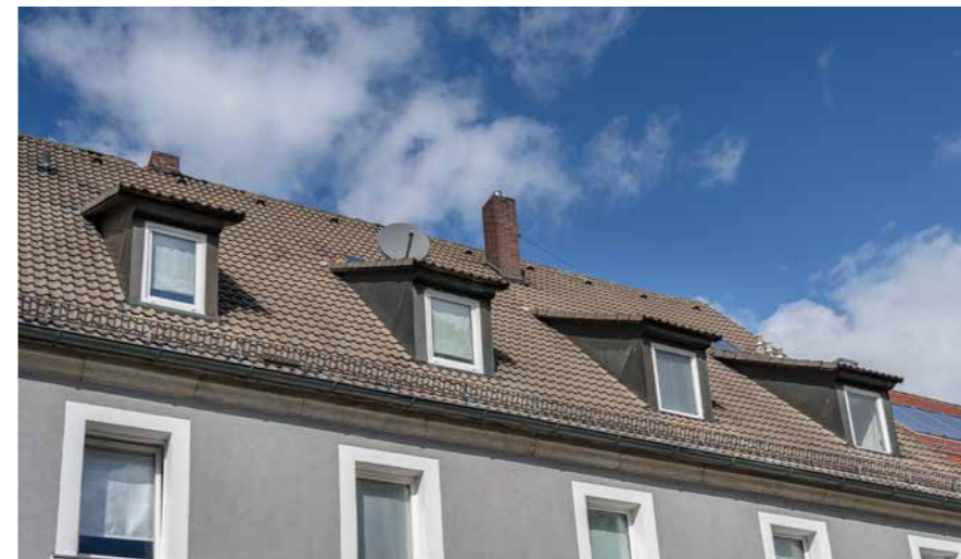
Breite der Gauben und Abstand von Gauben in der Reihe von mindestens zwei Sparrenfeldern
