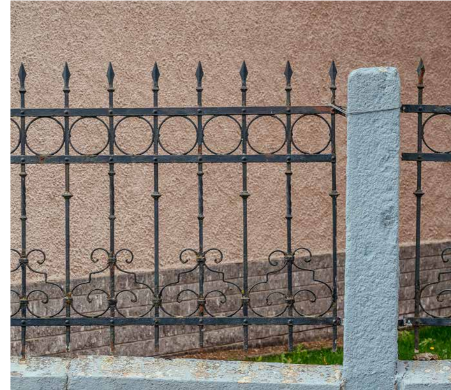
Natursteinpfeiler mit schmiedeiserner Einfriedung
