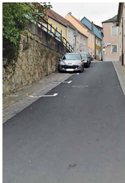
Einfassung einer asphaltierten Straße mit Pflasterstrandstreifen
