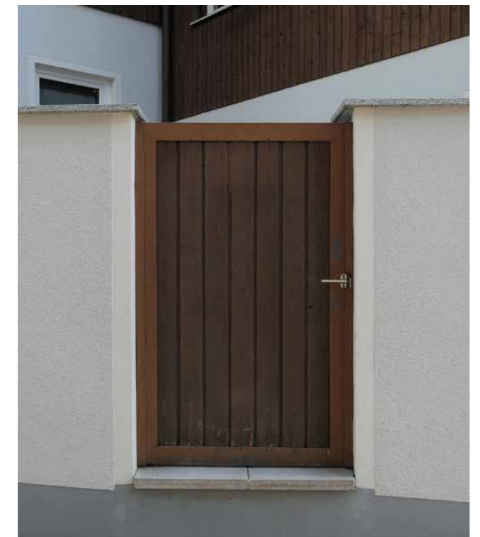
Einfriedungsmauer mit hölzerner Durchgangstür
