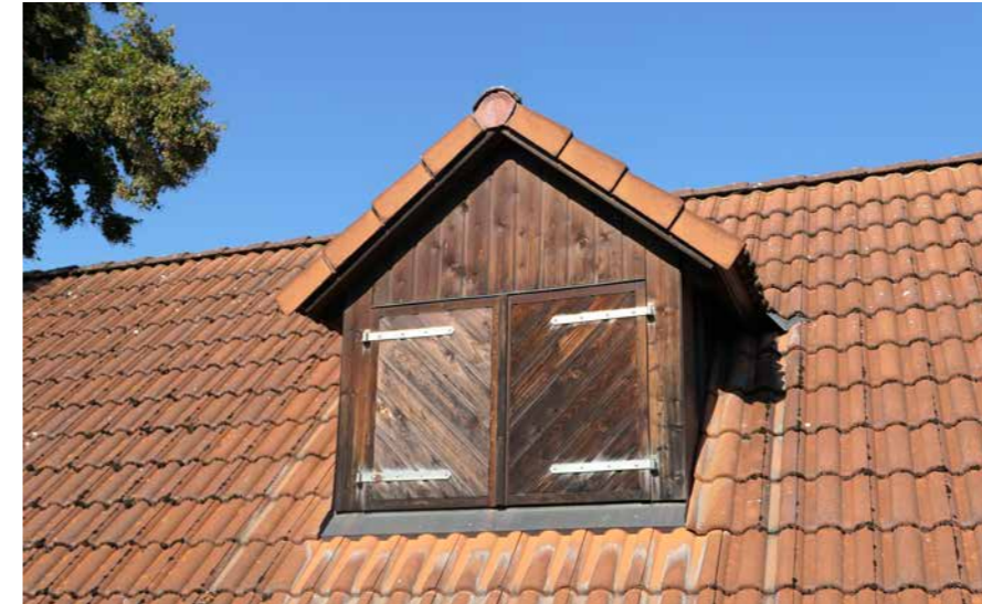
Äußerer Zugang eines Dachbereichs
