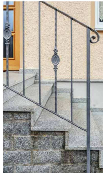
Traditionell geformte Absturzsicherung aus Schmiedeeisen
