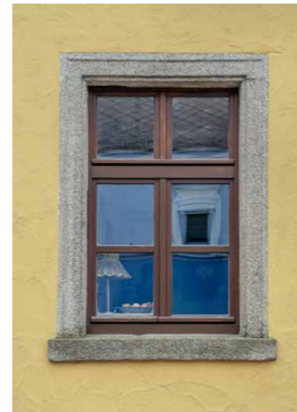
Hochstehendes Fenster mit historischer Binnengliederung
