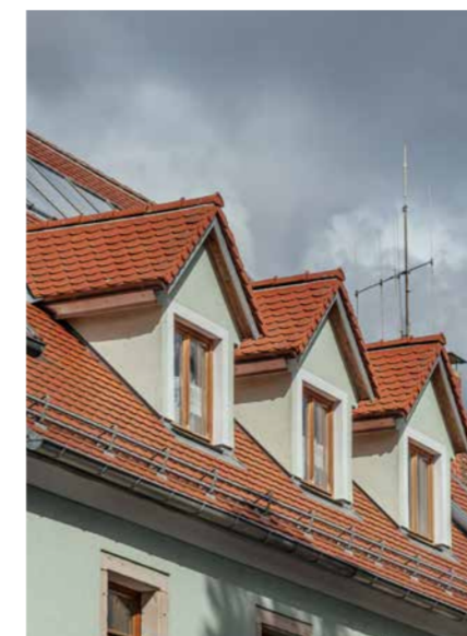
Gaubenform, Kehledeckung und Traufbildung
