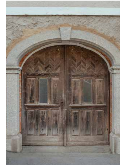
Typische Toranlage. Der Erhalt wird empfohlen
