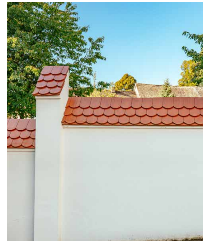
Einfriedung im Stadtbereich. Geputztes Mauerwerk mit Abdeckung aus roten Ziegeln
