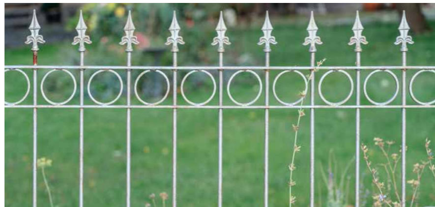
Beispiel für eine sachgerechte Einfriedung aus Schmiedeeisen
