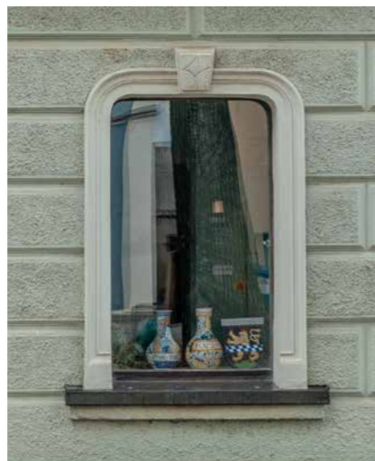
Erhaltenswertes Außenelement aus Naturstein
