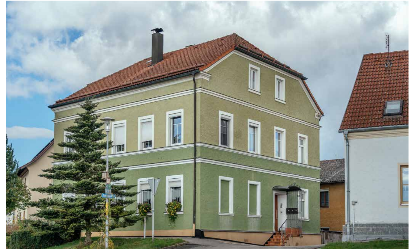
Haus mit Verschattungsanlagen
