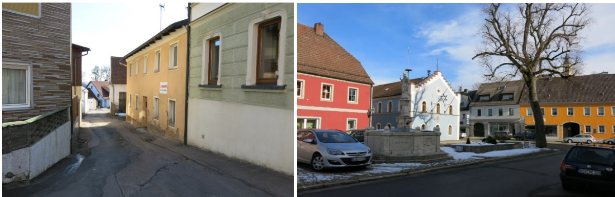
Abb. 28: Querbezug vom Marktplatz zur Ferdinand-Lehner-Allee sanierungsbedürftig, Historische Linde vor dem Rathaus und Brunnen mit Kriegerdenkmal am östlichen Ende des Marktplatzes (© LAB Röth)
