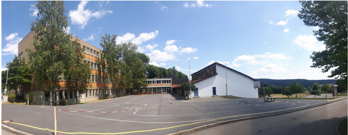
Abb. 37: Vorder- und Rückbereich der Grund- und Mittelschule (©|u|m|s| STADTSTRATEGIEN)
